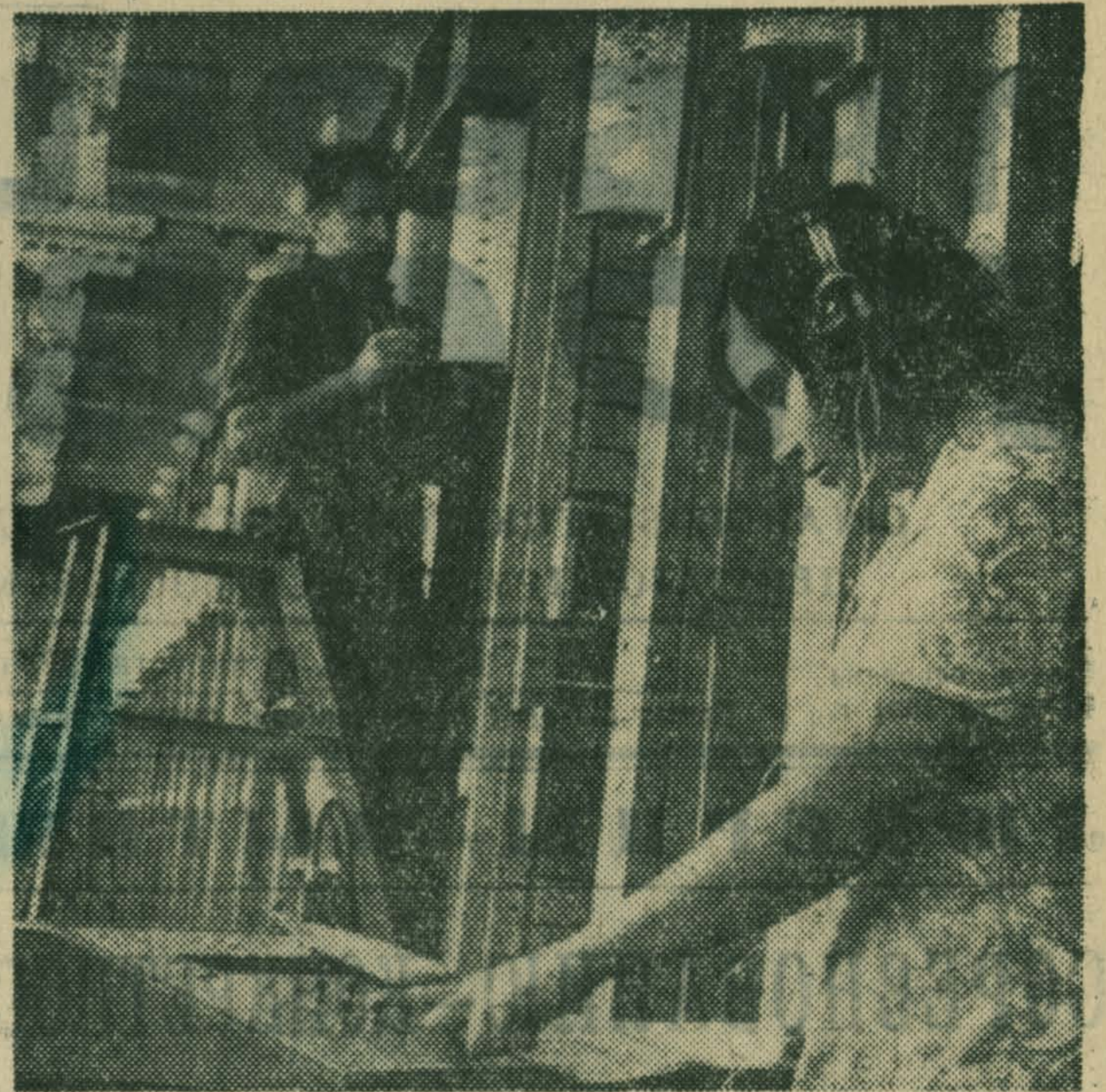
Подходят к концу основные пуско-наладочные работы на новой Люберецкой АЭС. Работники городского телефонного узла Анатолий Вандышев и Тая Ченцова — за установкой и проверкой работы аппаратуры.
