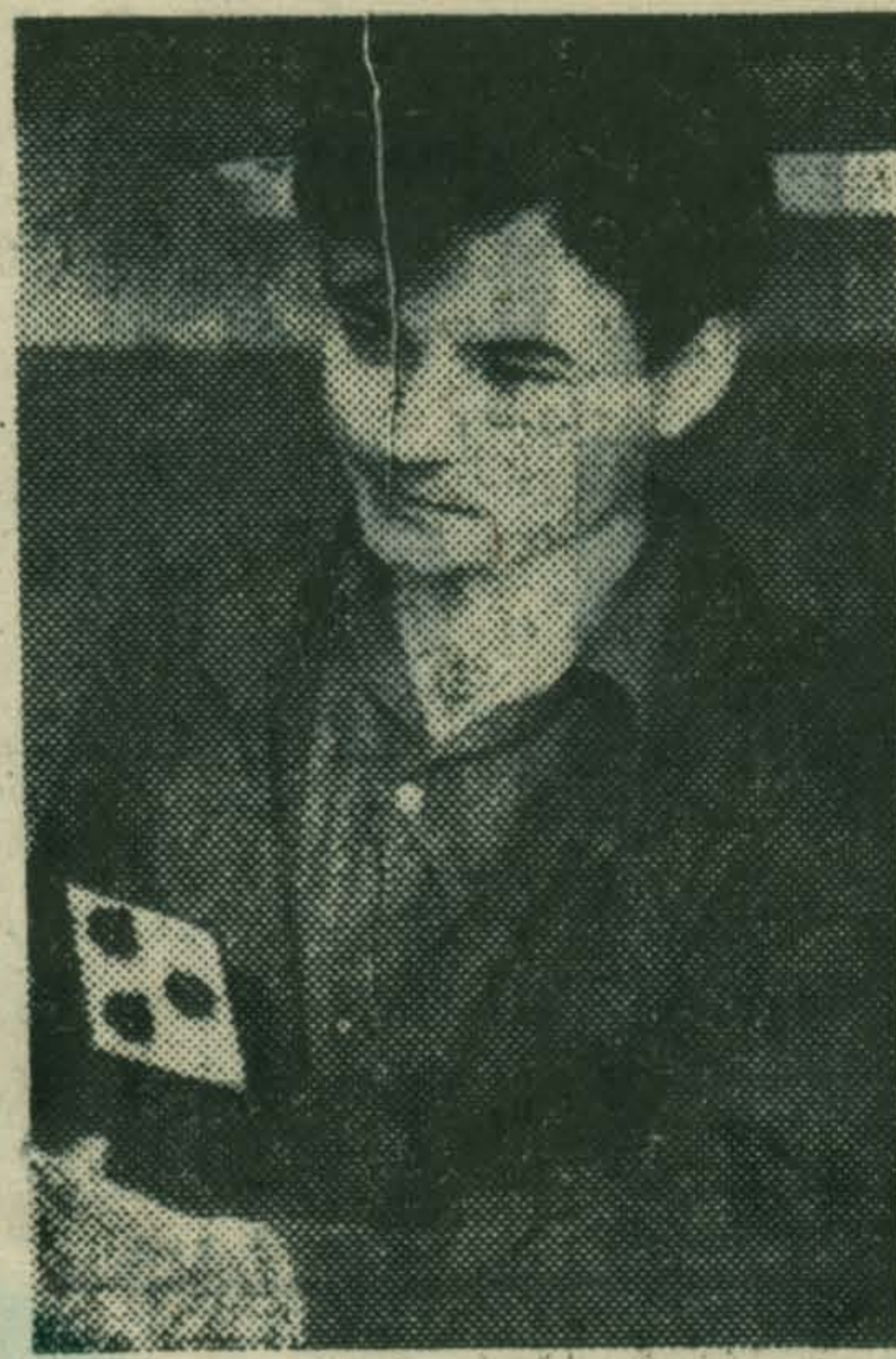
Электромонтажник Малаховского опытно-механического завода комсомолец Евгений Гуденко на монтаже нового оборудования. Фото Г. Скороходова.
